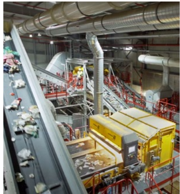
Die innovative Sortieranlage für Leichtverpackungen der Firma Hündgen hat eine Jahreskapazität von 85.000 t.
