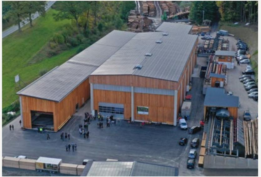
Luftaufnahme des Sägewerks: links das Sortier- und Stapelwerk, mittig die Sägewerkshalle und rechts der Rundholzplatz mit Rundholzaufgabe.
