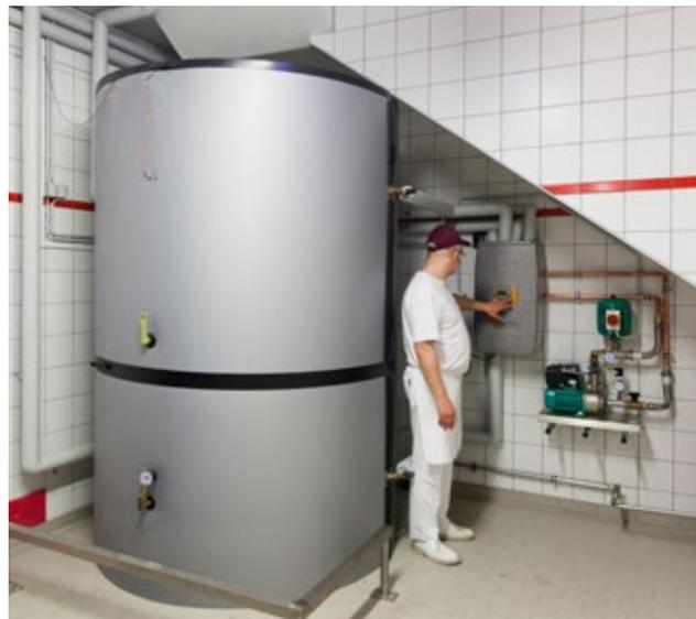
Die Wärmerückgewinnung umfasst drei Frischwassermodule.
