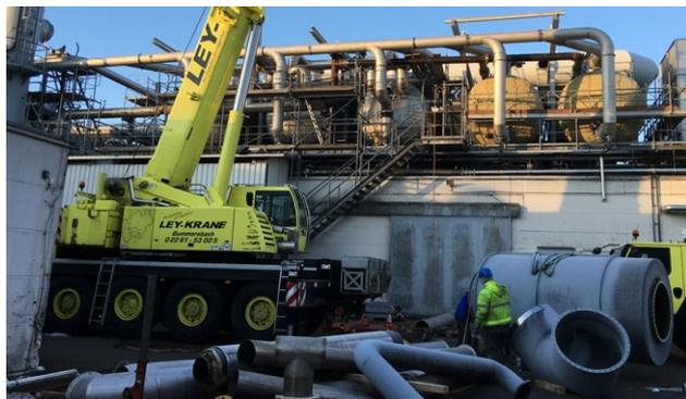
POLIFILM PROTECTION modifizierte die zur Adsorption des Benzins mit Aktivkohle gefüllten Adsorber aus den Beschichtungsanlagen.
