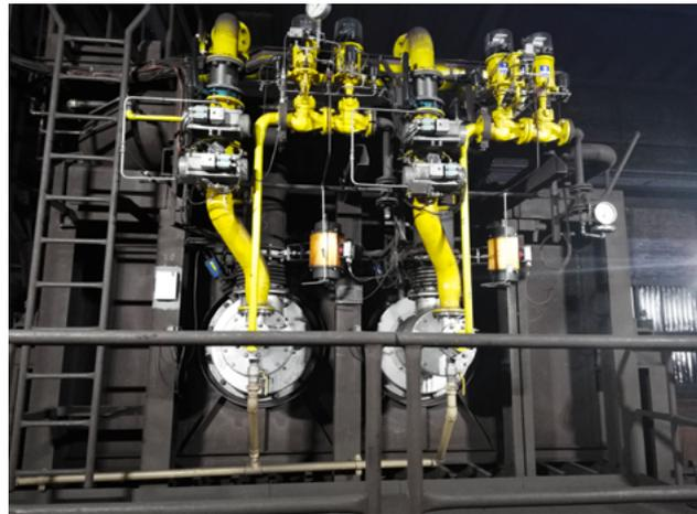
Die neuen Brenner können sowohl mit Gichtgas als auch mit Erdgas betrieben werden. Im Bild: zwei der vier neuen Brenner der Zündhaube.
