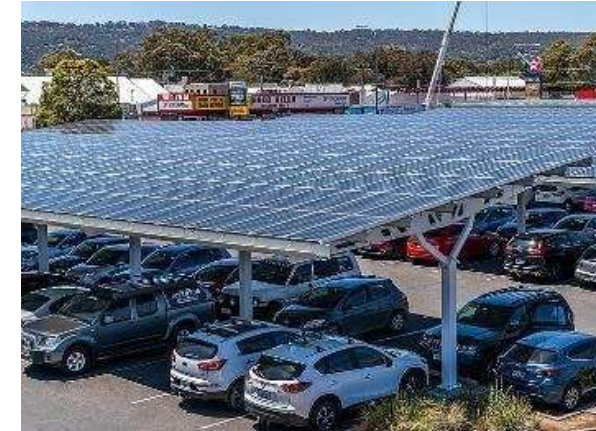
Quelle: © Wikimedia, Flicker 02 ( https://commons.wikimedia.org/wiki/File:Solar-Car-Park-PV-Structures.jpg )
